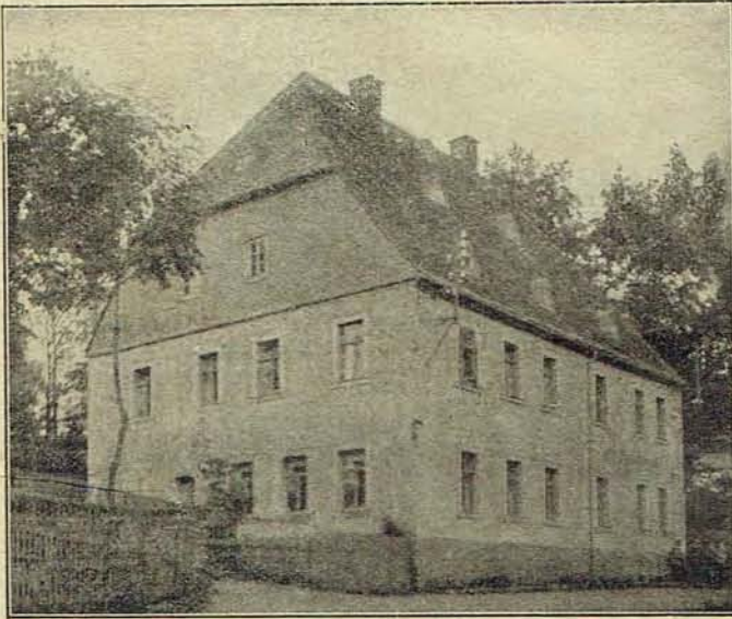
Das Schulhaus von 1802.
