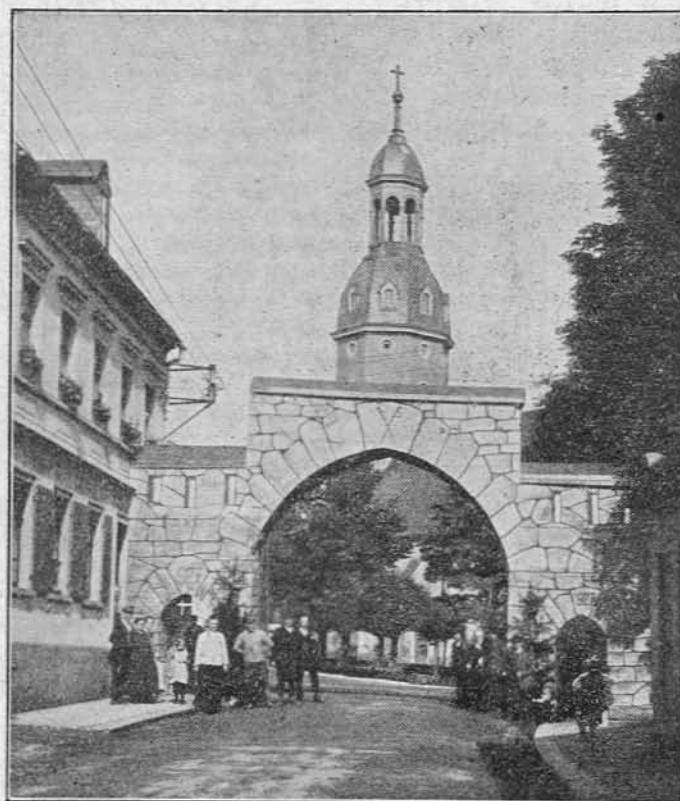
Nachbildung des ehemaligen Böhmisches Tores in Schlettau.
