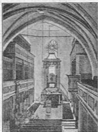
Blick nach dem Altarraum der alten St. Laurentiuskirche.
