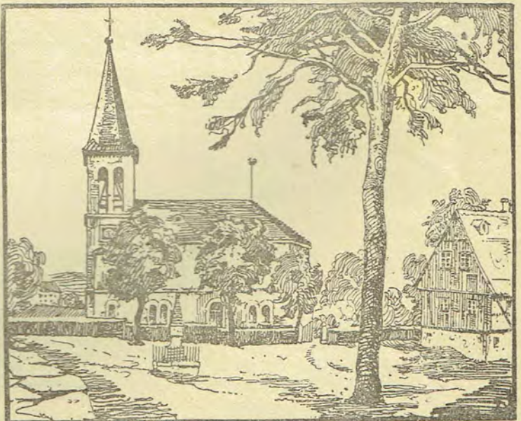
Die Kirche zu Geyersdorf.
