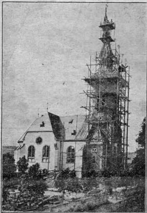
Die neue Kirche noch im Baugerüste des Turmes.
