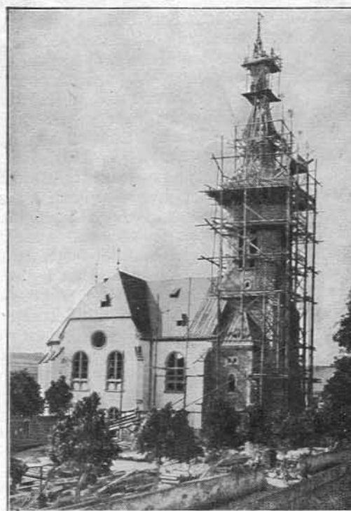
Die neue Kirche von Sehma noch im Baugerüste des Turmes.
