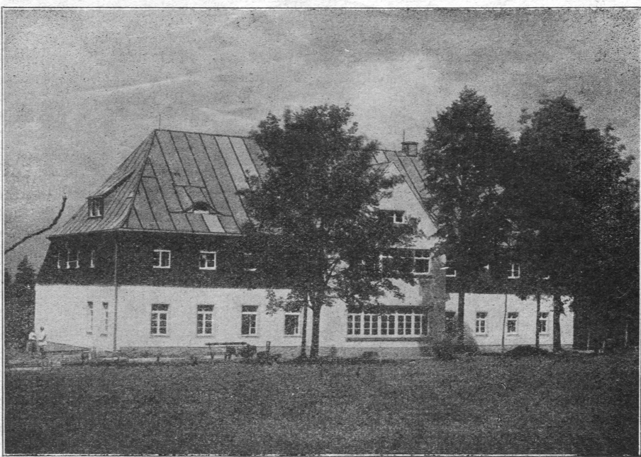
Das Schullandheim in Jöhstadt in jehiger Gestaltung.
