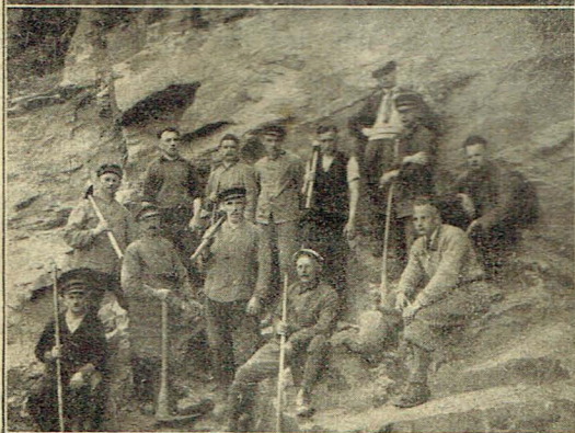
Bild oben: Die Bauleitung (4 Mann von links obere Reihe) mit ihrer Schachtkolonne.
