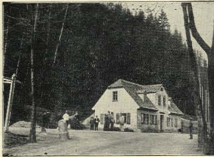
Das alte Buchholzer Chausseehaus.
