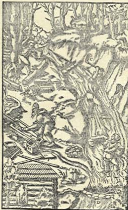
Zinnseifenwerk. (Zu unj. Artikel auf d. 1. Seite.) Der Bach A. Der Graben B. Die Breithaus C. Die Rajen D. Die Seifengabel E. Die eiserne Schaufel F. Der Trog G. Ein anderer dar- untergestellter Trog H.
