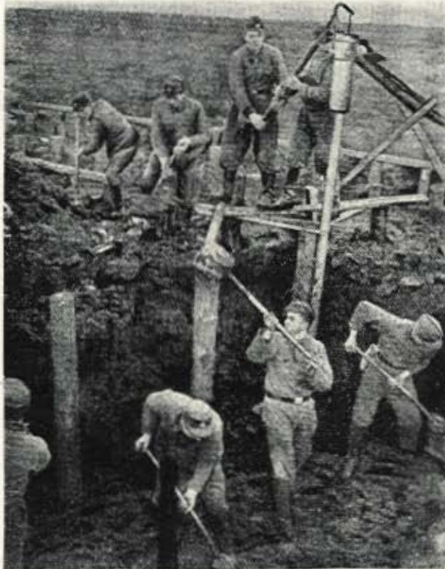
Aushebung der Baugrube für die Lagerbaracken. Während der Arbeit muß ununterbrochen das nachdringende Grundwasser mit einer Pumpe abgeschöpft werden.
