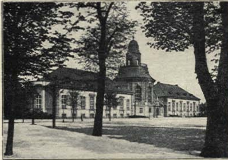
Gesamtansicht vom Städtischen Museum in Zwickau.
