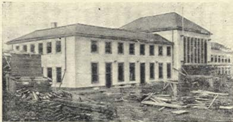
Der neue Flöhaer Bahnhof in der Zeit seines Baues. (Archiv A. 3., Chemnitz.)
