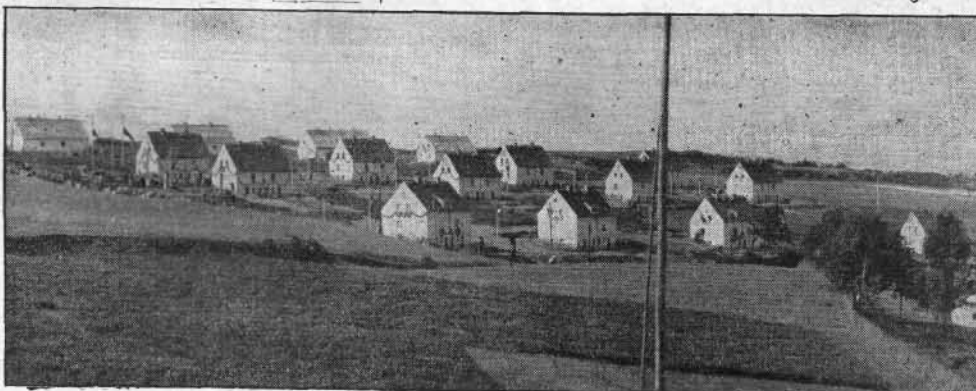
Gesamtansicht der Frontkämpfersiedlung mit Teitanstalt der Randsiedlung
