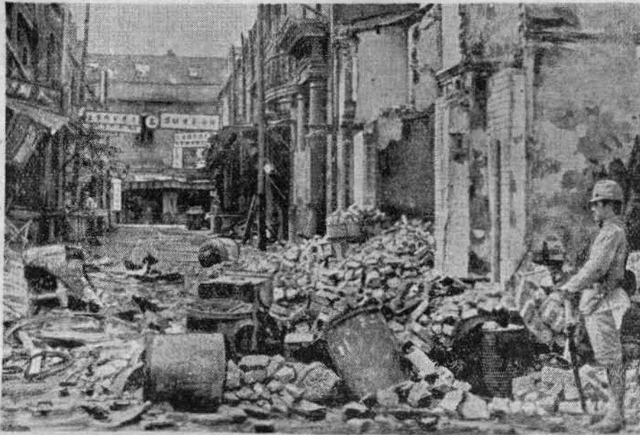
So sieht es im Schanghaier Bahnhofsviertel aus. Bei den Bombenangriffen der japanischen Flieger auf Schanghai wurde der Südbahnhof und die ihn umgebenden Straßen besonders getroffen, weil die japanischen Flieger dem Bahnhof seine strategische Bedeutung für chinesische Truppenverstärkungen nehmen wollten. — Die auf unserem Bilde sichtbare Straße grenzt unmittelbar an den Südbahnhof.
