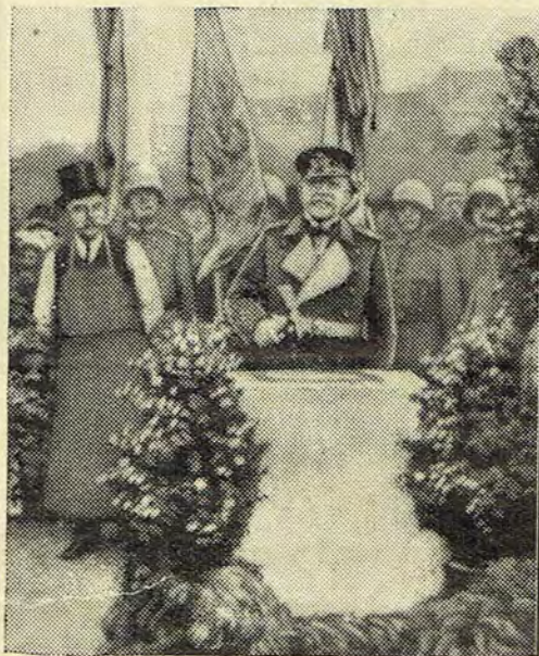
Grundsteinlegung des Ehrenmals für die ge- fallenen Seeloldaten in Kiel. — Vizeadmiral Schröder macht den ersten Hammerichlag.
